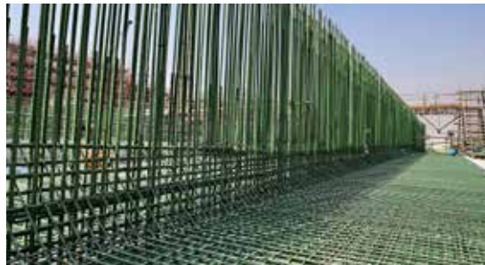
قضبان التسليح المغلفة بالإيبوكسي تستخدم في مشروع كهراء لإنشاء الخزانات الكبرى لتأمين المياه
